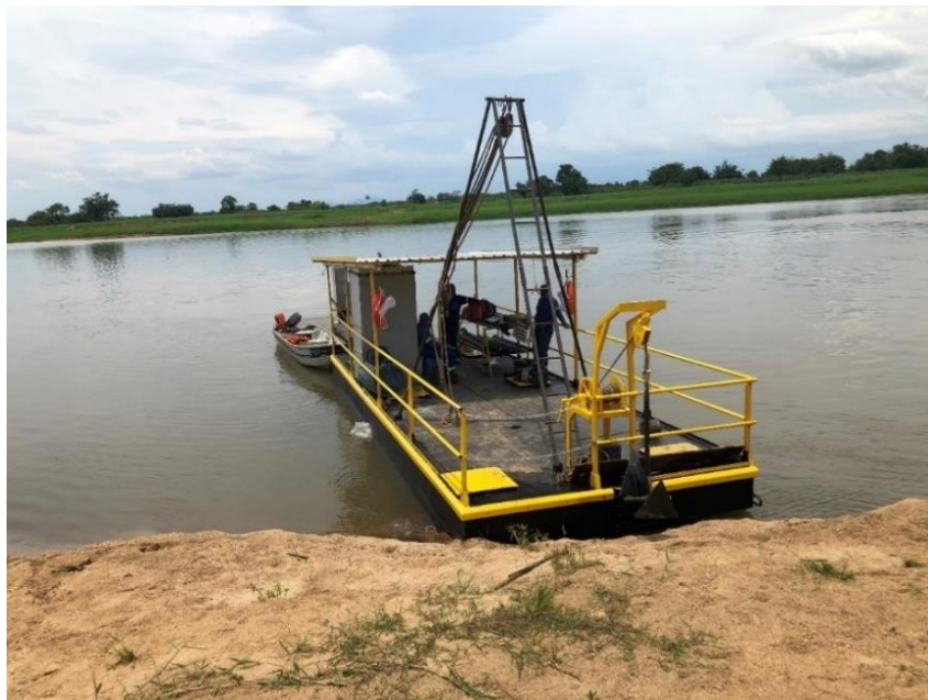
Foto 6.1 – Balsa equipada com tripé para as sondagens
